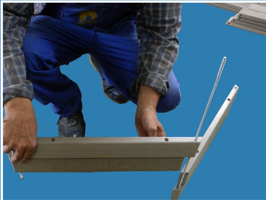
04 Składanie ścian donicy etap 1
