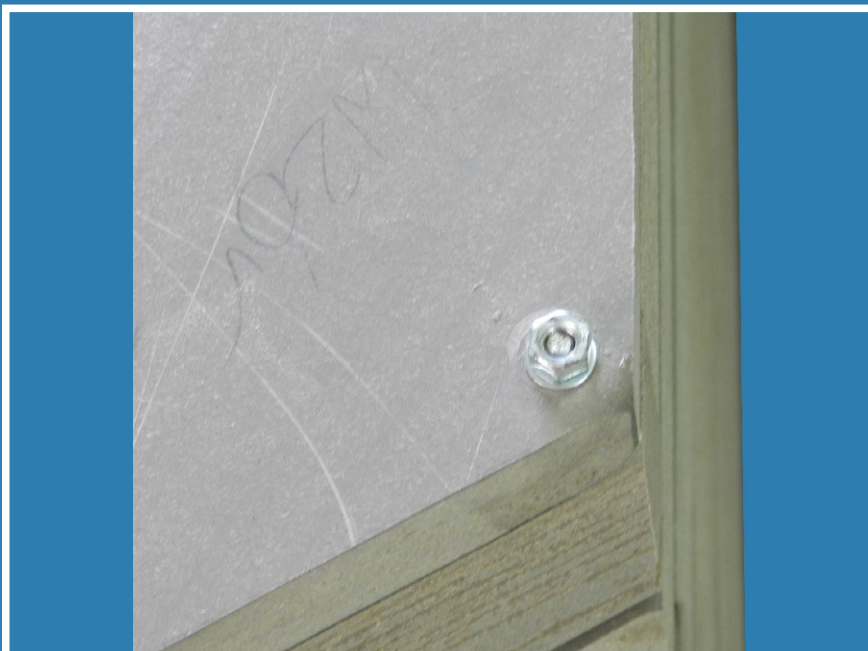
15 Montaż dna donicy etap 3: należy nałożyć podkładki oraz nakręcić mocno nakrętki na wszystkich sześciu prętach
